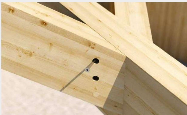
Unión vigueta-compluvio con tornillos HBS diámetro 8 mm.
